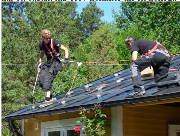
Montage av solceller på Sjöbacken t.v. Norrskan t.h.
